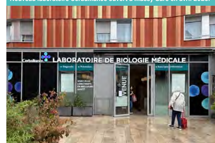
Nouveau laboratoire Cerballiance ouvert à Massy Gare en avril 2026.
